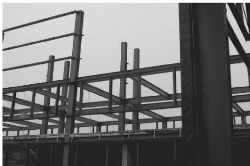
图 1 某钢框架房屋
