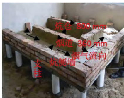
(b) 架空炕内部结构
