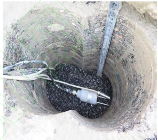
图 2 实测数据的现场布置
