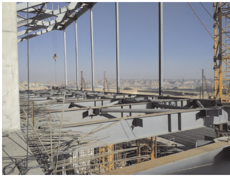
图 3 悬挑楼盖施工现场
