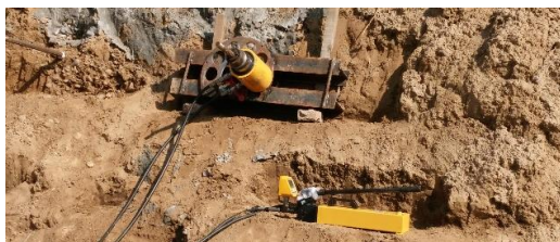
图10 试验加载 Fig. 10 Test loading
