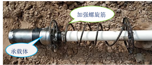
图11 可回收锚杆安装完成图
