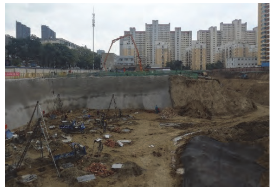
图 13 主楼处基础桩及“一桩两用”施工
