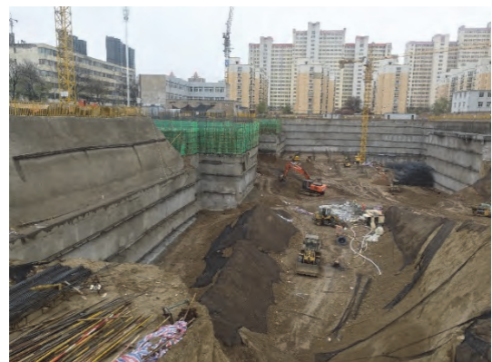
图 14 现场施工照片
