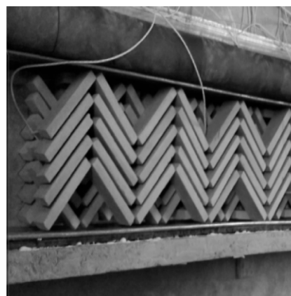
图1 储热装置内储热块的摆放图
