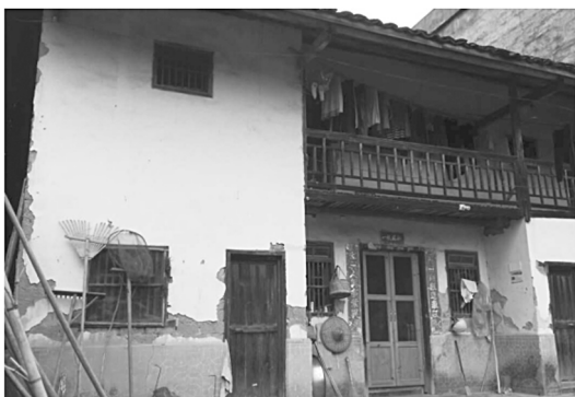
图1 江西省某生土结构房屋
