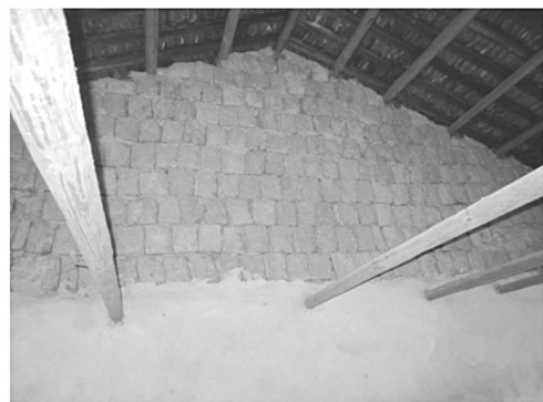
图2 屋面构造
