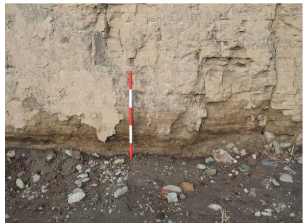
图2 降雨后地基中水分向遗址掏蚀区运移现象
