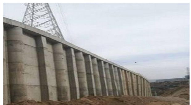
图 2 一级桩板墙施工完成图
